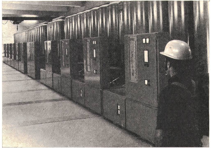
Fig. 3 SF 6 -isolierte Schaltanlage
