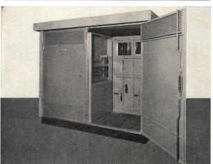
Satellitenstation für 2 bis 3 Hochspannungsleitungsfelder 24 kV, mit Normalendverschlüssen.
