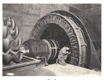
Fig. 2 Maschine «Bavona» in Montage 86 MVA, 428,6 U./min, 12 kV, 50 Hz
