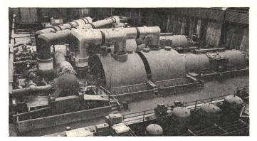
Fig.~21 Cross-Compound Turbogruppe Cumberland der TVA, 1300 MW, 60 Hz
