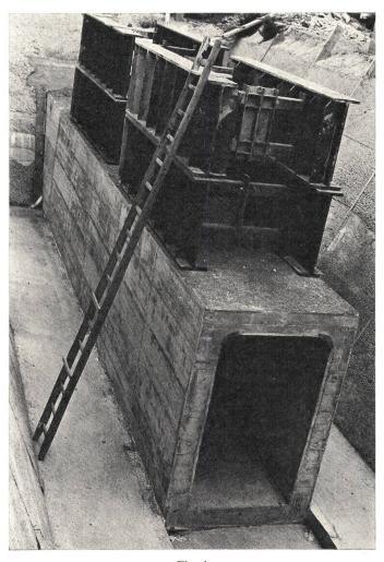
Fig. 4 Vorfabriziertes Schachtteilstück
