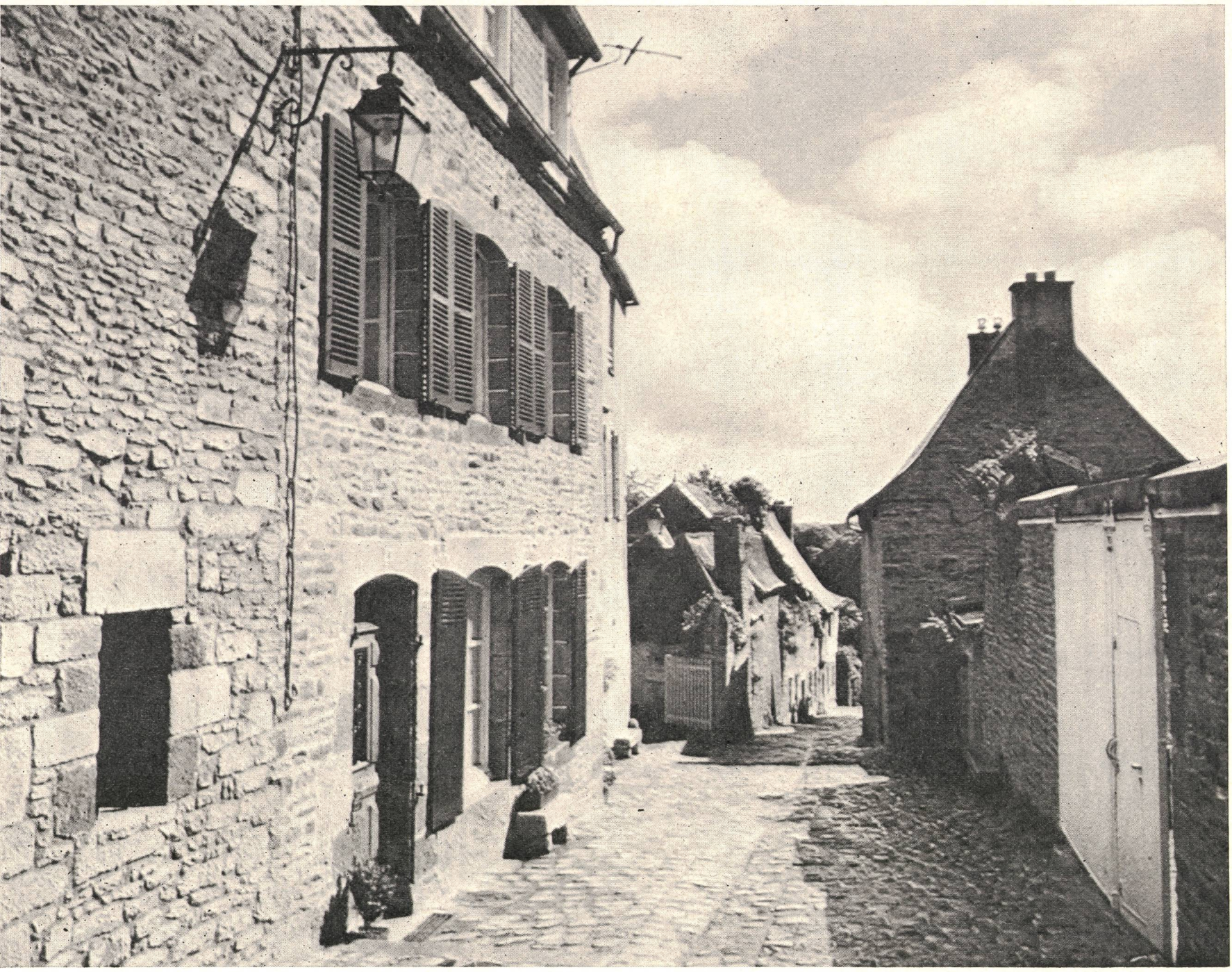
Fig. 4 Niederspannungsverteilung mittels Fassadenkabel
