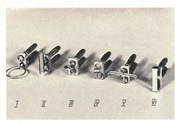
Fig. 22 **Typische Impulshärte-Induktoren**Erläuterungen siehe im Text
