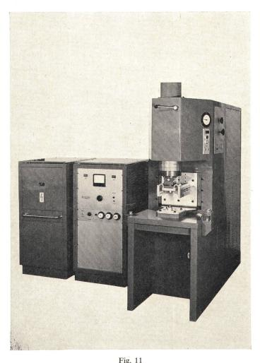
Ultrapuls-Großschweissmaschine für 12 000 Ws
