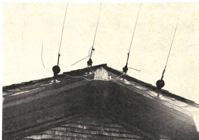
Fig. 10 Tödlicher Unfall beim Versuch, die Drähte eines neuen Kraftanschlusses mit der Freileitung zu verbinden
