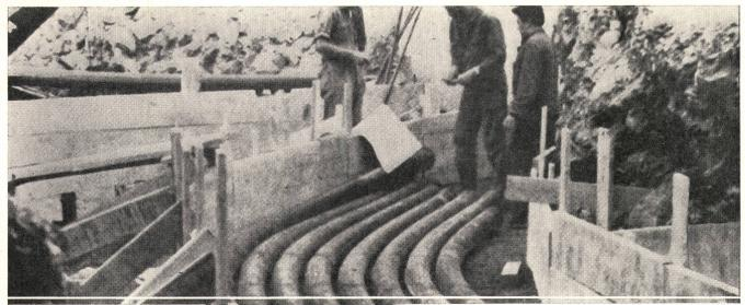
EINFÜHRUNGS-ROHRE (aus Asbestzement)
