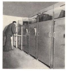
Unser standardisiertes Geräteprogramm kann leicht in die Zellen eingesetzt werden. Ölstrahlschalter, Lasttrenner und Messapparate auf Wagen bilden ein einheitliches, ausfahrbares Trennwagensystem. Die fest in den Zellen eingebauten Apparate bleiben gut zugänglich. Mit den modernen Kabelendverschlüssen kann heute jedes beliebige Kabel eingeführt werden. Verkürzte Montagezeiten werden durch anschlussfertige Bauteile nach dem Baukastensystem erreicht.
