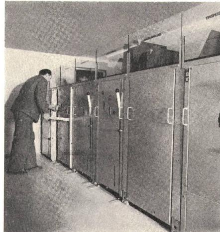
Unser standardisiertes Geräteprogramm kann leicht in die Zellen eingesetzt werden. Ölstrahlschalter, Lasttrenner und Messapparate auf Wagen bilden ein einheitliches, ausfahrbbares Trennwagensystem. Die fest in den Zellen eingebauten Apparate bleiben gut zugänglich. Mit den modernen Kabelendverschlüssen kann heute jedes beliebige Kabel eingeführt werden. Verkürzte Montagezeiten werden durch anschlussfertige Bauteile nach dem Baukastensystem erreicht.
