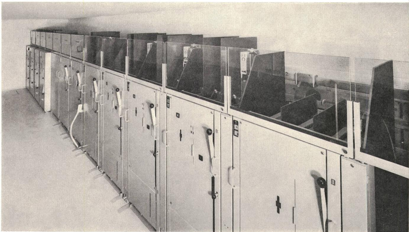
Eine zukunftsweisende Technik reduziert den Platzbedarf gegenüber Zellen konventioneller Bauart um 55%. Zwei Meter Raumhöhe genügen, um die einheitlich 750 mm breiten Zellen für 12 und 24 kV aufzunehmen.
