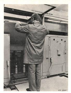
Fig. 17 Einschieben der Schutzplatte
