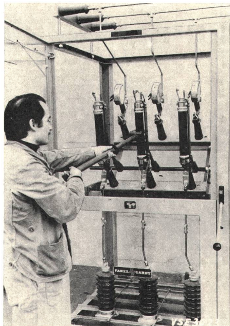
Fig. 2 Zweitelliger Berührungsschutz aus Sekurit-Glas
