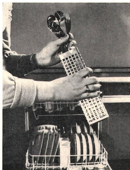
Der Silberputzkorb besteht aus einer besonderen Aluminium-Legierung. Im Zusammenwirken mit der Spülflüssigkeit löst sie eine elektrochemische Reaktion aus. Durch sie wird das auf dem Besteck vorhandene Silbersulfid zu metallischem Silber und Schwefel reduziert. Während der Schwefel in die Spülflüssigkeit gelangt, bleibt das Silber metallisch mit der Silberauflage verbunden.
