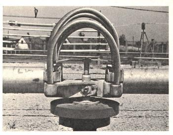
Fig. 2 Leitungsträger mit Reibdämpfer
