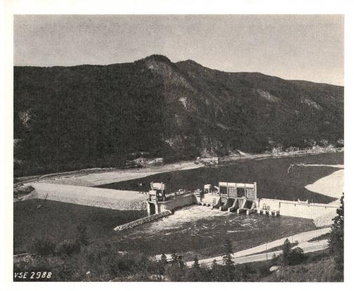
ment errichtet worden. Der Erddamm dagegen, der den eigentlichen Flussquerschnitt absperrt, liegt auf einer Schicht der Sand- und Gesteinablagerungen, welche die Flußsohle bilden. Da die grosse Tiefe des Flußstroms (bis 35 m) und das weiche Fundament die Errichtung einer Baugrube sehr erschweren würden, wurde der Erddamm einfach durch das Entladen des Baumaterials aus den Barken ins Wasser errichtet.
