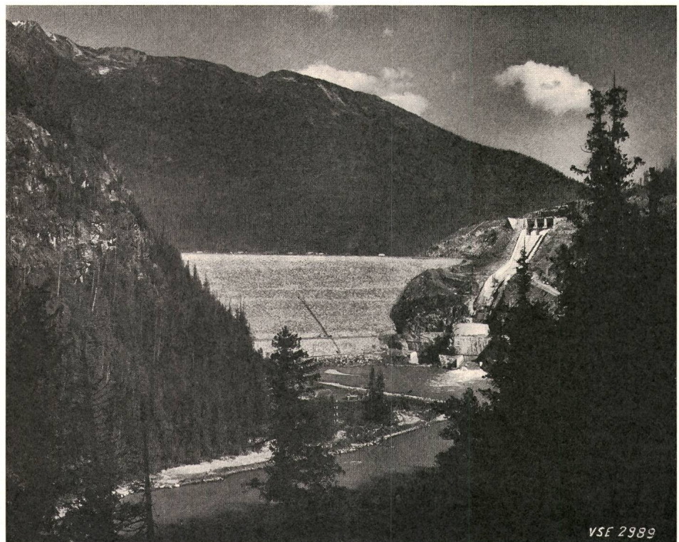
Fig. 14 Der Mica Staudamm im Bauzustand Über die Höhe des fertiggestellten Damms kann man aus der Lage des Überfallwehrs (rechts) urteilen
