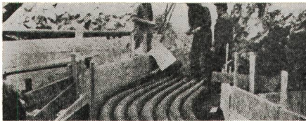
EINFÜHRUNGS- RÖHRE (aus Asbestzement) Wasserdichte Mauerdurchführung für SYMALEN- Kabelschutzröhre.
