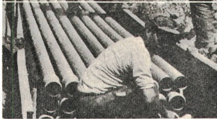
DOPPELMUFFEN MIT PROFILGUMMRINGEN Das ideale Verbindungselement für SYMALEN- und SYMADUR-Kabelschutzröhren. Der Profilmuffen gewährleistet ein dichtes Rohrleitungssystem. Vor dem Aufschieben der Doppelmuffe auf das Rohr muss das angeschragte Rohr mit Dichtmittel bestrichen werden.
