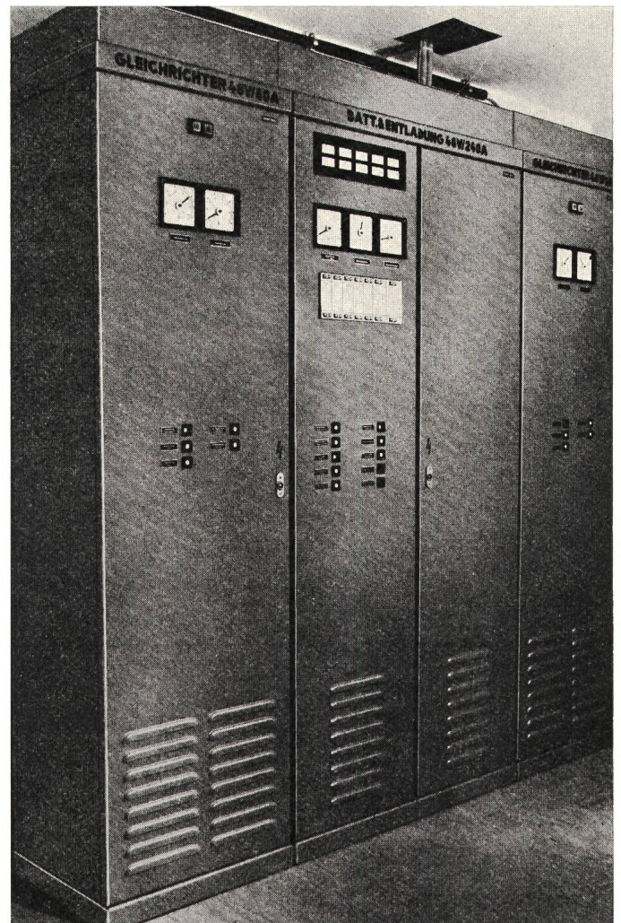
Fig. 7 Stromversorgungsanlage 48 V/Typ 240 A mit Gleichrichtern von 60 A
