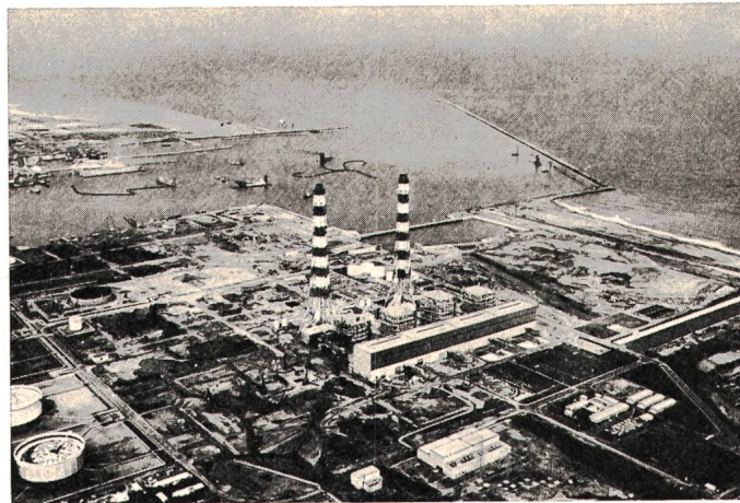
Fig. 1 Ölkraftwerk Kashima der TEPCO mit 4 × 600 MW und 2 × 1000 MW Endausbauleistung
