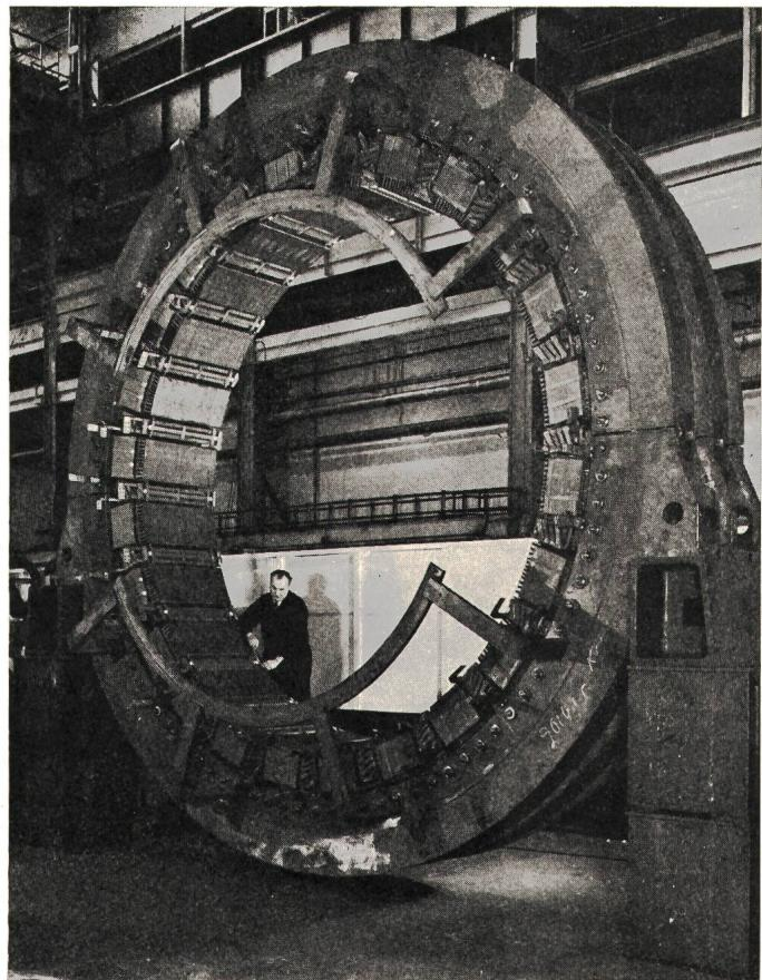
**Ein Gleichstrommotor für eine Bergwerksförderanlage** in Übersee hat mit einer Leistung von 11 000 PS und einer Drehzahl von 76 U/min einen Durchmesser von nahezu 6 m. Der komplette Motor wiegt 123 t. Der Rotor des Motors ist direkt mit der Seiltrommel der Förderanlage gekuppelt. Dadurch konnte man auf das Unterstellungsgetriebe verzichten und die Gesamtbreite der Anlage erheblich reduzieren.
