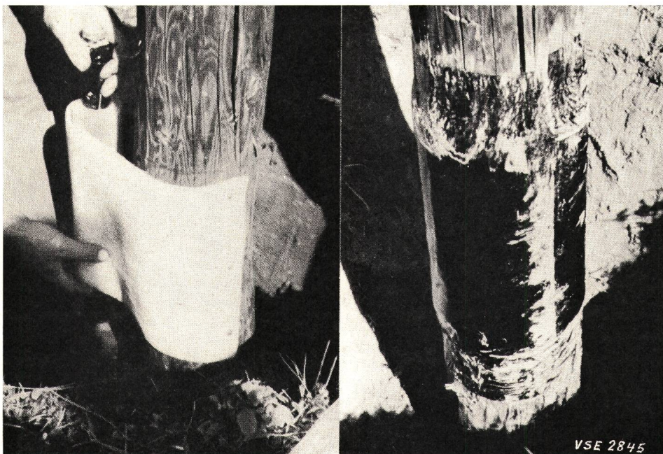
Fig. 7 Nachpflege eines Leitungsmastes in Einbau- zone mit Schaumstoff-Fertigbandage.
