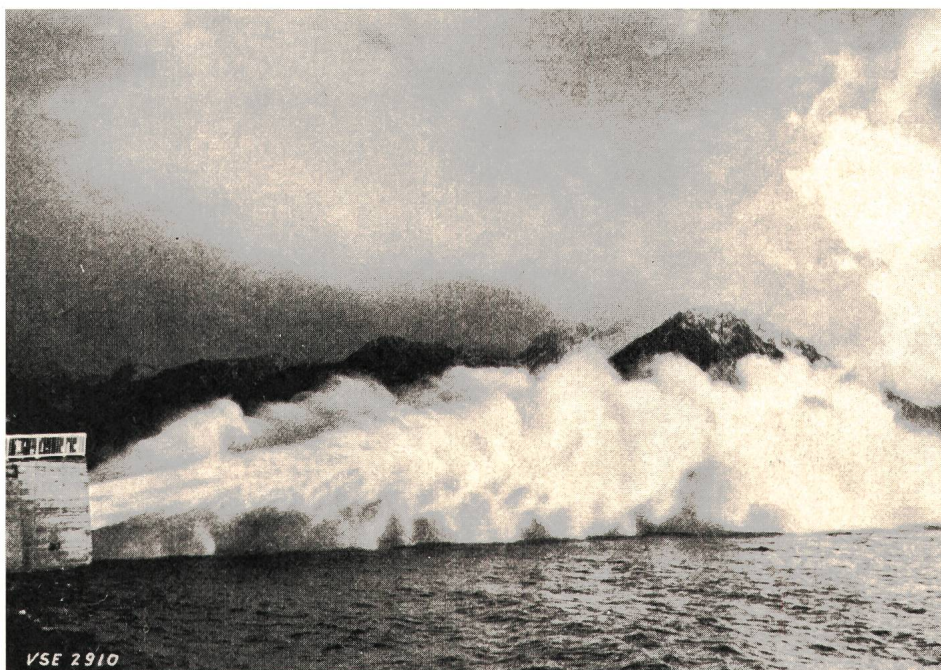
Prüfung des Grundablasses des Kraft- werkes Hongrin-Léman
