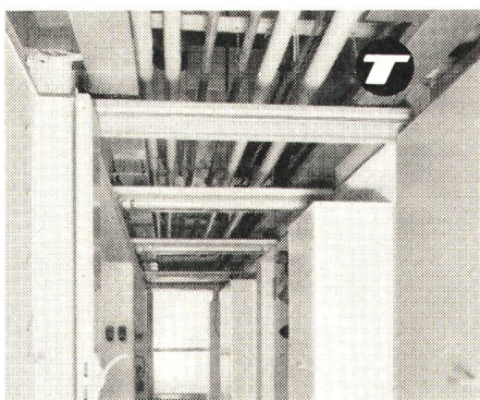
Zwischendecken-Installation in biolog. Institut
