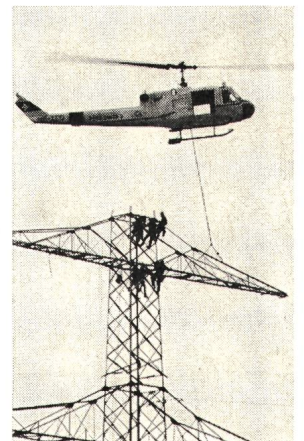
Aufstocken eines Oberteils
