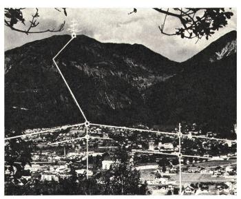
${\bf Fig.~1} \\ {\bf Prim\"{a}r~und~Sekund\"{a}rkabelstr\"{a}nge~einer~Fernsehgrossverteileranlage} \\$
