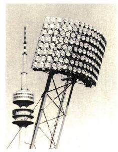
wickelte Siemens-Olympia-Lichtfluter eingesetzt. Das Bild zeigt einen der beiden mit jeweils 144 Scheinwerfern bestückten Masten. Ein ebenfalls neuentwickeltes Zündgerät ermöglicht nach kurzzeitigem Stromausfall eine sofortige Wiederzündung der noch betriebsheissen Lampen.
