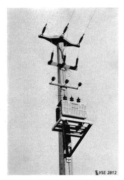
$Fig. \ 3$  Station auf Mast aus vorgespanntem Beton ohne Mittelspannungssicherungen
