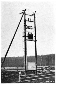
Fig. 5 Vollständig ausgerüstete Maststation
