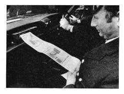
dung vielleicht unmöglich wäre. Identitätsbilder oder maschinengeschriebene Auskünfte sind gleich geeignet zur Eingabe in die meisten Funksender, wobei das Empfangsgerät automatisch eingeschaltet wird. Die Übertragung findet über das Funknetz in Form frequenzmodulierter Impulse statt, die dann zurückverwandelt die Auskunft auf elektroempfindlichem Papier wiedergeben.
