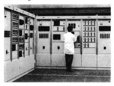
Nicht nur bei der Projektierung nützen Ihnen die Vorzüge des Einschubsystems NSE 2. Da Verdrahtung und Funktionsprüfung im Werk vorgenommen werden, liefern wir betriebsfertig. Das bedeutet kurze Montagezeit.
