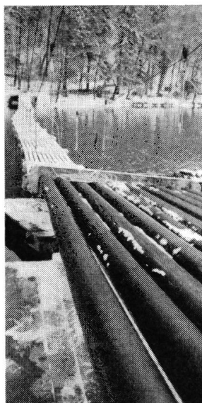
Verlegung von Kabel- schutzrohren in die Arve/Genf
