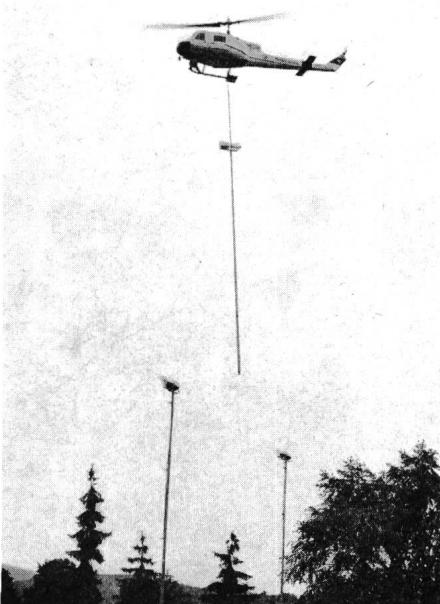
Zürich, wurden kürzlich auf den Sportplätzen der Schweizerischen Rückversicherung in Adliswil eingesetzt. Den Transport der 15,5 m langen Masten über den Baubestand der Sportanlage und die Zäune der Tennisplätze besorgte ein Helikopter der Heli-swiss.
