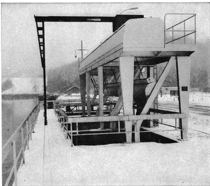
Kühlwasserfassungen der Atomkraftwerke Beznau I und II. Je 3 Rechen und automatische, stationäre Rechen-Reinigungsmaschinen.
