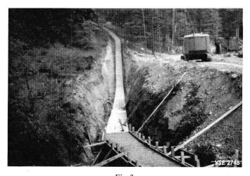
Fig. 3 Kunststoffrohrblock mit 32 Rohren 124/120 mm Durchmesser
