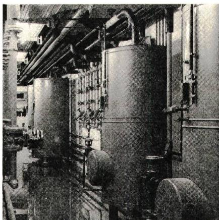
Elektrische und kombinierte Boiler bis 10000 l Inhalt Elektrische Dampf- kessel SVDB
