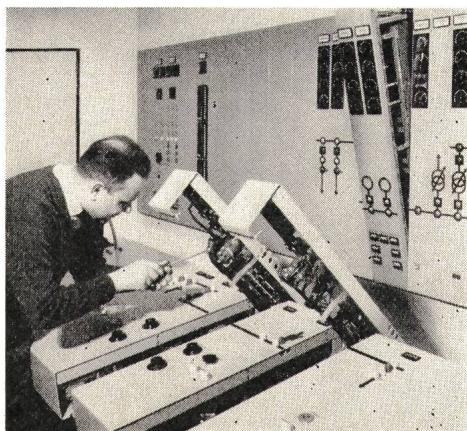
Der äussere Sicherheitsfaktor heisst also «funktionelle Übersichtlichkeit». Allebetriebsnotwendigen Steuer-, Regel- und Überwachungseinrichtungen fassen wir in logische Einheiten zusammen. Schutzrelais, Schreiber, Messwertumformer, Zähler usw. werden meistens im Apparateraum oder in Relaihäusern der Schaltanlage untergebracht. So ergibt sich ein vorbildlicher Kommandoraum, der ein zuverlässiges Steuern und Überwachen gewährleistet.
