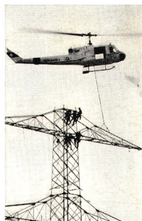
Aufstocken eines Oberteils
