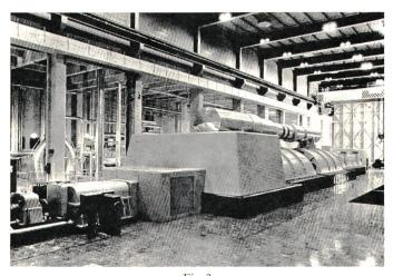
Fig. 3 377-MW-Turbosatz des Kraftwerkes Santurce
