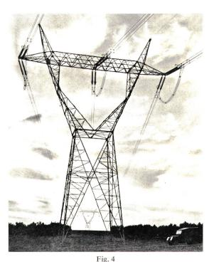
380-kV-Abspannmast mit Viererbündel
