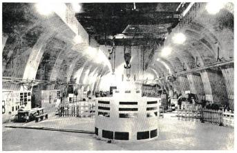
Fig. 2 Maschinenhaus Alcántara mit 4 Maschinensätzen zu je 289 MW
