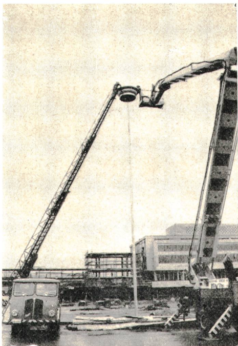
Fig. 5 Montage et réglage d'un luminaire
