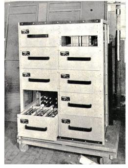
Fig. 22 Gleichrichter der Fig. 21 mit geöffnetem Einschub Oben rechts die Steuerelektronik der Tore
