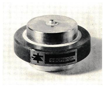
Fig. 19 Scheibenthyristor mit Luftkühlung
