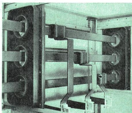
Druckentlastung nach oben, doppelte Blechwände oder Picalplatten zwischen den Zellen erhöhen die Sicherheit der Baureihe. Die Bedienungsfront ist komplett abgedeckt und bietet wirksamen Schutz des Personals. Eine zufällige Berührung der unter Spannung stehenden Teile ist somit ausgeschlossen. Klemmeständer, die in der ganzen Höhe von vorne zugänglich sind, gewährleisten gefahrloses Arbeiten. Eine Einschubplatte unter der Sammelschiene dient bei Kabelarbeiten dem erhöhten Schutz.
