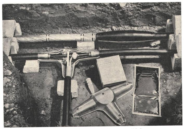
Giessharz-Kabelarmaturen zur Verbindung aller Kabeltypen:
