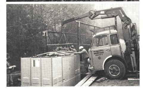
Grösste Sicherheit durch gekapselte, berührungsgeschützte Schalteinheiten; vollisolierte Verschalung.
