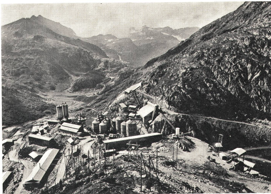
Bogenstaumauer Emosson (Höhe 180 m, Betonvolumen 1,1 Mio. m 3 ) Bauinstallationen für die Sand- und Kiesaufbereitung sowie für die Betonherstellung und Kabelkrane Photo M. Darbellay, Martigny
