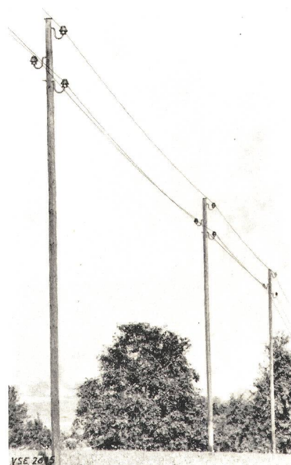
20 kV-Regelleitung (max. Spannweite 50 m) 1-strängig; auf Holzstangen
