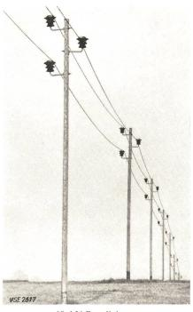
60 kV-Regelleitung (max. Spannweite 50 m) 1-strängig; auf Holzmasten
