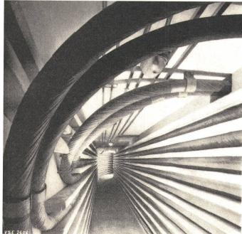
Fig. 8 Kabelanordnung in einem begehbaren Kabelkanal
