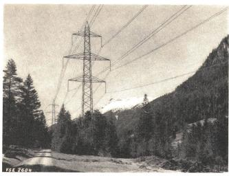
Fig. 6 Doppelsträngige 380 kV-Freileitung
