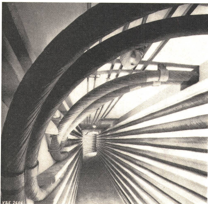
Fig. 8 Kabelanordnung in einem begehbaren Kabelkanal
