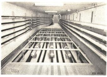
Fig. 9 Beispiel einer Muffenanordnung für 220 kV-Kabel
