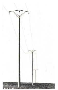
20 kV-Weitspannleitung 1-strängig; auf Betonmasten
