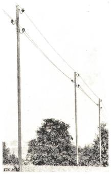
20 kV-Regelleitung (max. Spannweite 50 m) 1-strängig; auf Holzstangen
