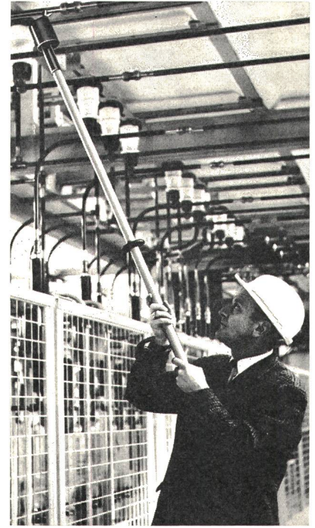
Peyer-Optictest in 16 kV Innenraum-Schaltanlage
