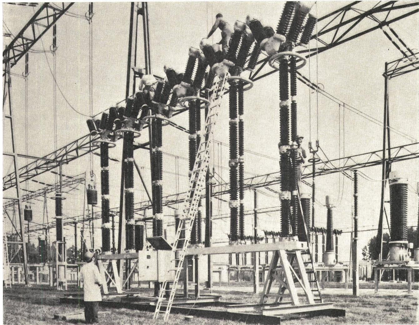
Ein geradliniger Weg führt von der Inbetriebnahme unseres ersten Ölstrahl-Schalters mit Mehrfachunterbrechung für 400 kV im Jahre 1960 in Schweden zur Entwicklung des neuesten Typs dieser Bauart, dem ersten ölarmen Schalter für 765 kV. Dieser hat im Oktober 1969 nach bestandener Typenprüfung unser Werk verlassen und gehört zur Lieferung von drei Schaltergruppen für die Hydro Quebec in Kanada.
