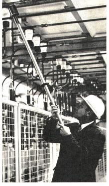
Peyer-Optictest in 16 kV Innenraum-Schaltanlage
