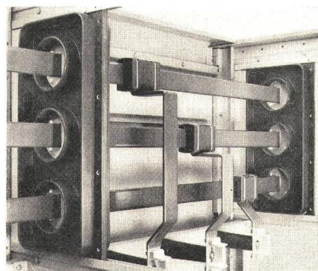
Druckentlastung nach oben, doppelte Blechwände oder Picalplatten zwischen den Zellen erhöhen die Sicherheit der Baureihe. Die Bedienungsfront ist komplett abgedeckt und bietet wirksamen Schutz des Personals. Eine zufällige Berührung der unter Spannung stehenden Teile ist somit ausgeschlossen. Klemmständer, die in der ganzen Höhe von vorne zugänglich sind, gewährleisten gefahrloses Arbeiten. Eine Einschubplatte unter der Sammelschiene dient bei Kabelarbeiten dem erhöhten Schutz.
