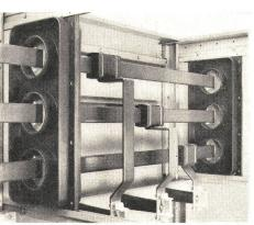
Druckentlastung nach oben, doppelte Blechwände oder Picalplatten zwischen den Zellen erhöhen die Sicherheit der Baureihe. Die Bedienungsfront ist komplett abgedeckt und bietet wirksamen Schutz des Personals. Eine zufällige Berührung der unter Spannung stehenden Teile ist somit ausgeschlossen. Klemmenständer, die in der ganzen Höhe von vorne zugänglich sind, gewährleisten gefahrloses Arbeiten. Eine Einschubplatte unter der Sammelschiene dient bei Kabelarbeiten dem erhöhten Schutz.
