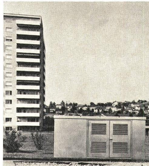
Das Gehäuse besteht aus verzinktem Metall mit Deckfarbe. Die Station wird mit eingebautem Transformator auf ein einfaches Fundament aufgesetzt. Er ist auch durch das Dach oder eine Seitenwand ausbaubar.
