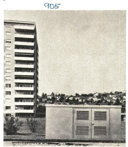
Das Gehäuse besteht aus verzinktem Metall mit Deckfarbe. Die Station wird mit eingebautem Transformator auf ein einfaches Fundament aufgesetzt. Er ist auch durch das Dach oder eine Seitenwand ausbaubar.
