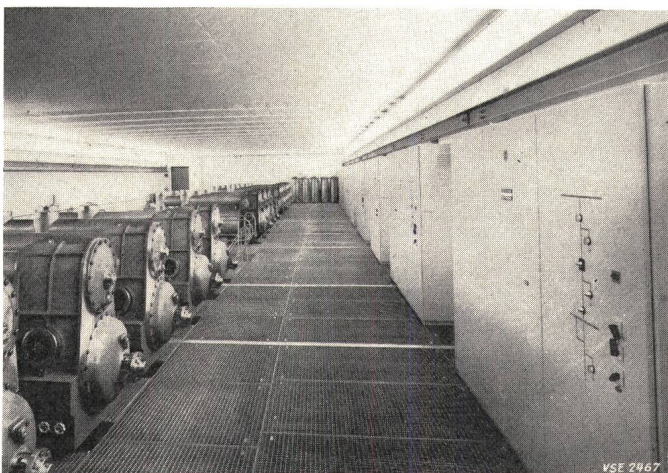
150-kV-Schalterraum und örtliche Steuertafeln
