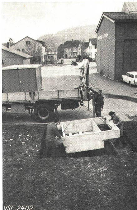
Fig. 9 Sprecher & Schuh-Station Einbringen der Fundament-Konstruktion
