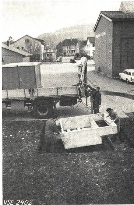
Fig. 9 Sprecher & Schuh-Station Einbringen der Fundament-Konstruktion
