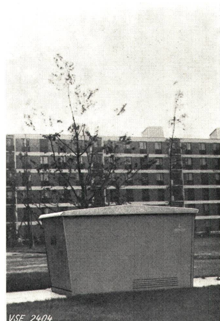
Fig. 11 Kompakt-Transformatorstation 400 kVA, Reihe 20 kV
