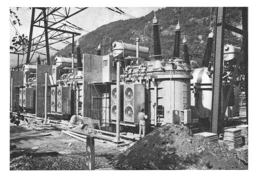
Fig. 3 Montagebild einer 600-MVA-Transformatorengruppe 400/220 kV in Lavorgo
