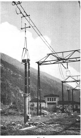
Fig. 5 Montagebild eines Pantographen-Trenners für 400 kV mit Druckluftantrieb von 25 atü
